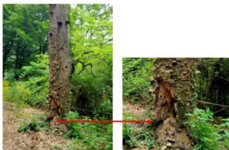
Figura 5 Evidenti tracce di insetti xilofagi su faggio
