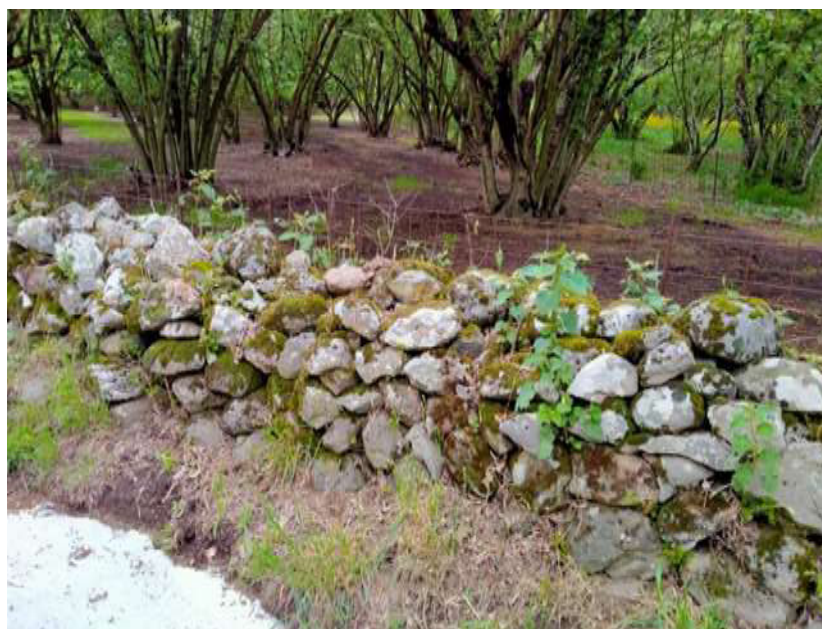
Figura 31 Muretto a secco di confine con nocciolo
